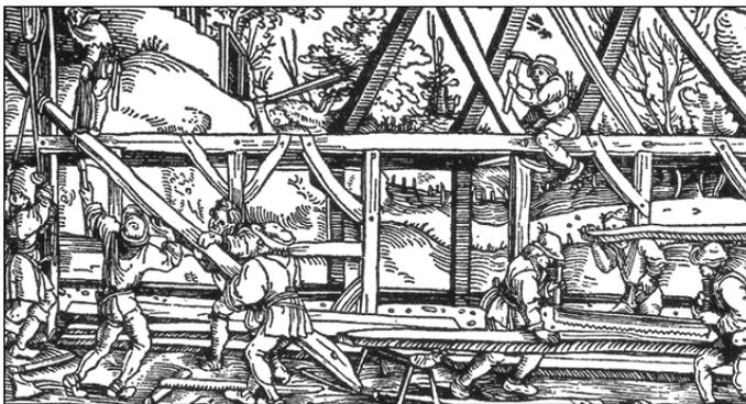
**Bild 1.2** Petrarca: Bau eines Fachwerkhauses um 1520
