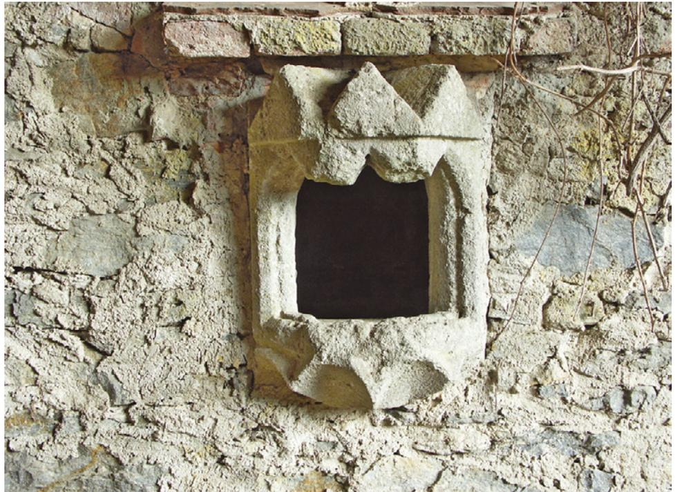
**Abb. 7:** Erdgeschoß des Abtshauses. Sekundär verwendetes Lichthäuschen, das nun die Funktion eines Fensters erfüllt. Foto: Bundesdenkmalamt.
