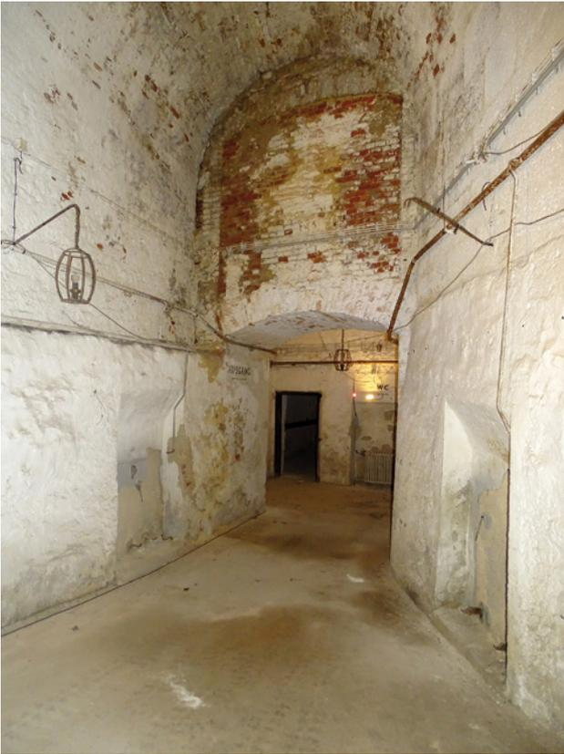
**Abb. 52:** Wiener Neustadt, Kasematten. Strada coperta, Raum KG.13/süd (Ansicht gegen Südosten). Oberhalb des erst im 19. Jahrhundert ausgebrochenen Durchgangs durch die Stadtmauer befindet sich eine vermauerte Portallaibung des 16. Jahrhunderts, die vermutlich auf einen Geschützhof führte.
