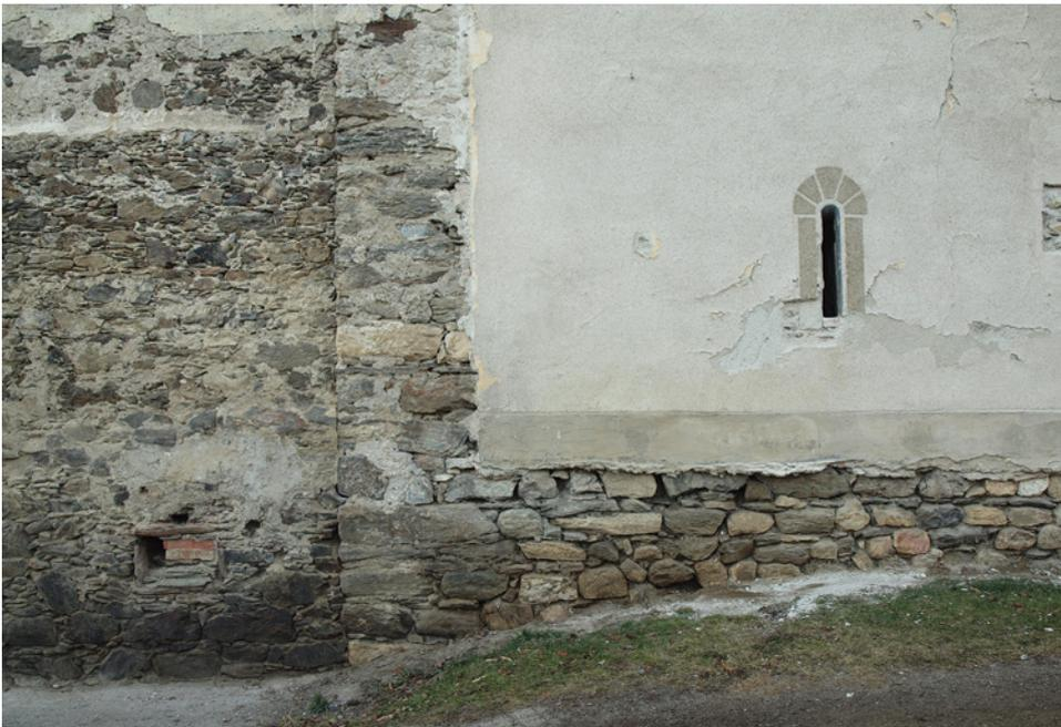
**Abb. 5:** Micheldorf, Thurnhof. Detail der Ostfassade mit dem spätromanischen Mauerwerk des Kernbaus (rechts) und dem Mauerwerk der frühneuzeitlichen Ausbauphase (links). Im Bild ist die vertikale Baufuge zwischen Kernbau und Erweiterung deutlich erkennbar.
