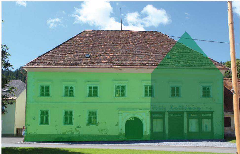
**Abb. 2:** Grades, Platzkrämerhaus. Nordfassade zum Marktplatz. Kernbau und spätgotisch-frühneuzeitliche Erweiterung sind farblich herausgehoben.
