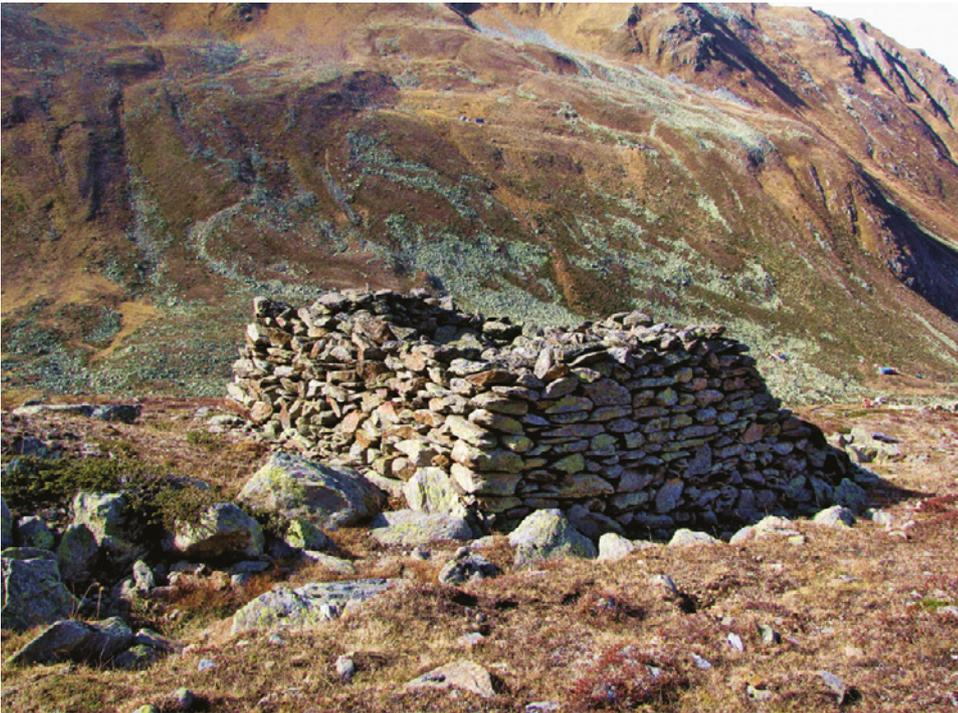
**Abb. 11:** Mastfuß 13 der Materialseilbahn im Platzertal. Foto: Burkhard Weishäupl.
