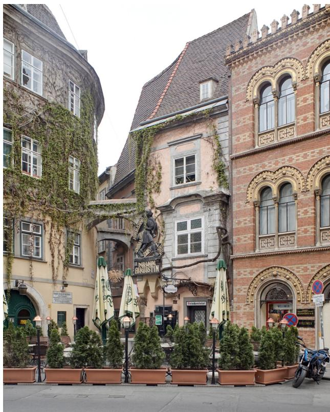
Abb. 16 Über dem „Griechenbeisl“ am Fleischmarkt 11 (056) befindet sich nicht nur das älteste profane Dach Wiens, sondern auch eine der steilsten Dachflächen. Auf dem sich verjüngenden Gebäudetrakt in der Griechengasse wird die Firsthöhe beibehalten und die Dachfläche damit auf über 80 Grad angesteilt.
