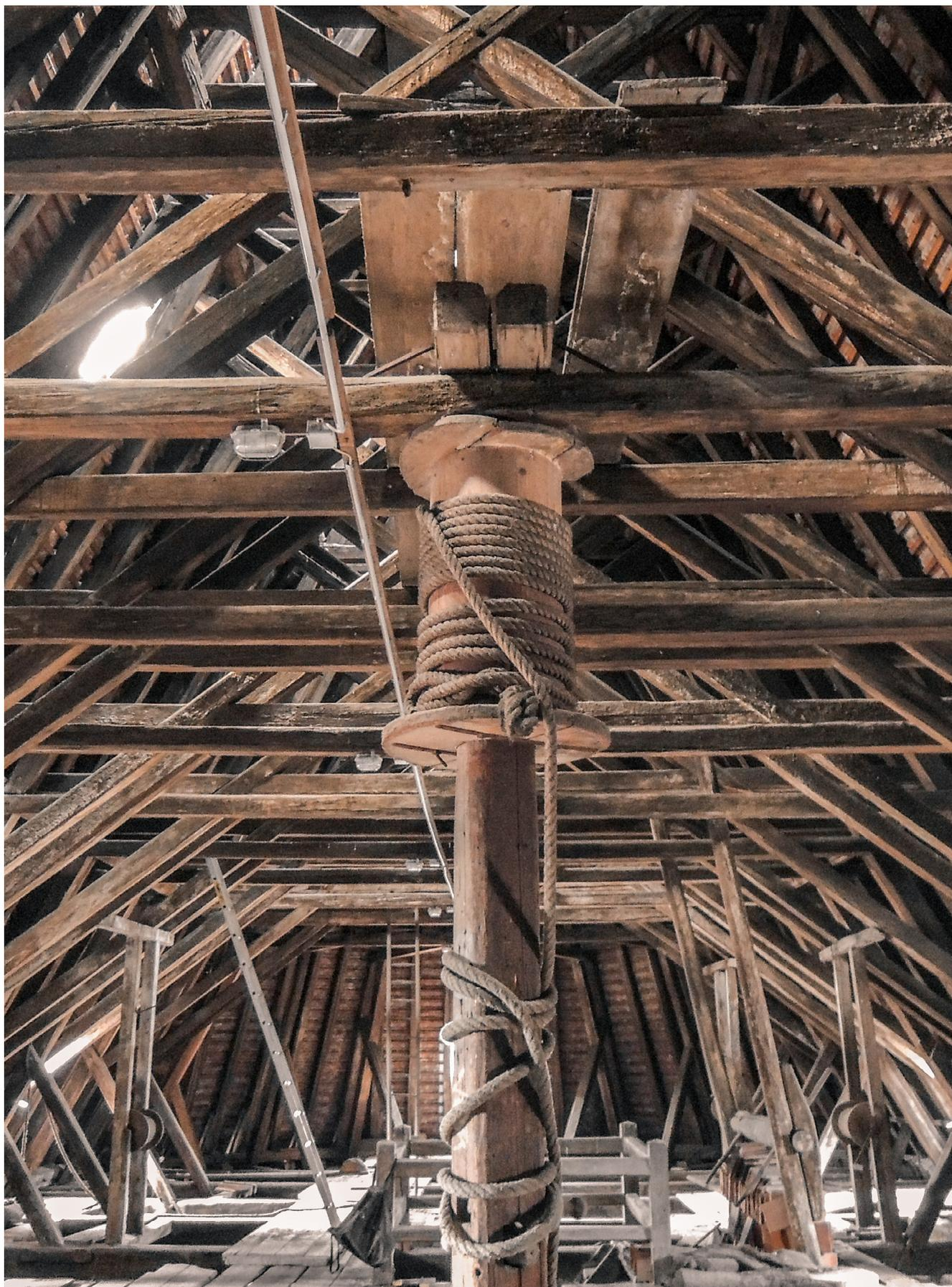
**Abb. 31** Im Dachwerk von 1353 über dem Chor der Kirche Maria am Gestade (001) entsteht durch den Wechsel von jeweils zwei Leergespärren mit Kreuzstreben und einem Vollgespärre mit abgesetztem Untersparren ein verwirrendes Labyrinth aus Hölzern. Zudem ist die Kehlbalckenlage im Vollgespärre unterbrochen und nur ein tiefer gesetzter Spannriegel als Auflager für die Längsträger ausgeführt, womit die Horizontallinien in der Raumtiefe ebenfalls verspringen (Abb. 34b).
