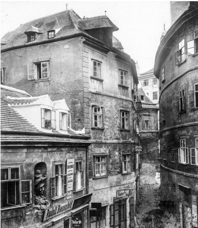
**Abb. 20** Auf dem hohen Haus in der Griechengasse links im Bild, das zum Fleischmarkt 11 (059) gehört, befindet sich eine Holzschindeldeckung, mit der auch die Grate, Kehlen und Gaupen ausgeführt wurden. Im Vordergrund sind die First- und Randziegel des Daches am Hafnersteig 6 gerade frisch in Mörtel gesetzt worden. Die Fotografie ist kurz vor 1900 entstanden.
