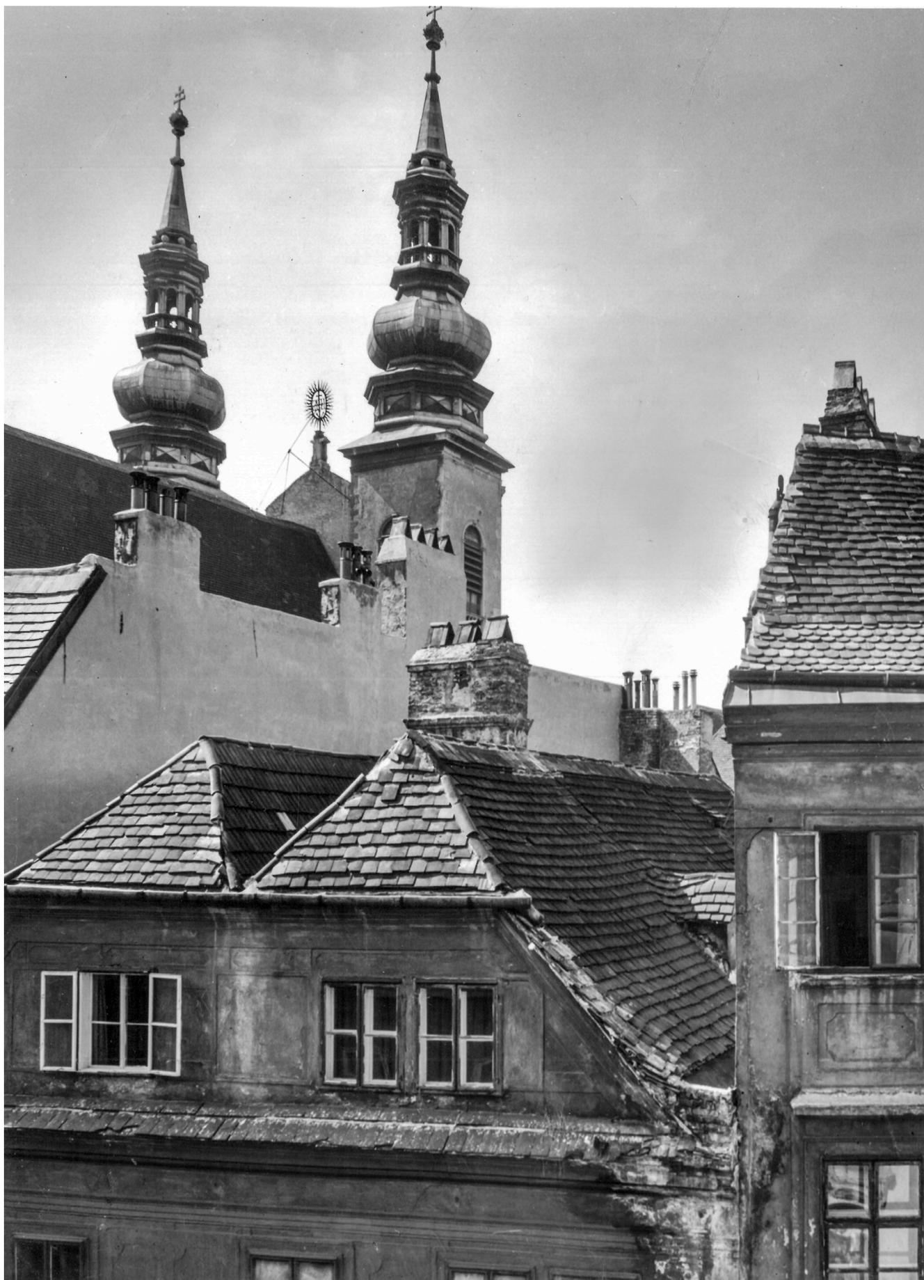
**Abb. 14** Die Fotografie aus dem Jahre 1955 zeigt das Firstgrabendach in der Schönlaterngasse 6 (151), das in dieser Form noch heute erhalten ist. Die Giebelmauer ist massiv ausgeführt, die beiden Satteldächer oberhalb sind abgewalmt. Mittlerweile ist die Dachwohnung mehrfach modernisiert und die Ziegeldeckung erneuert worden. Im Hintergrund erheben sich, damals wie heute, das Dach (045) und die Türme der Jesuitenkirche.
