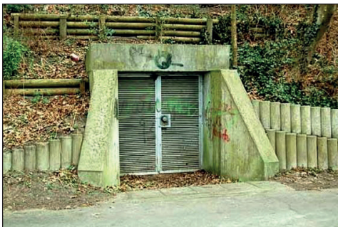
■ Hangstollenbunker, 710 Plätze – Bremen Rönnebeck, Bürgermeister-Dehnekamp-Weg.
