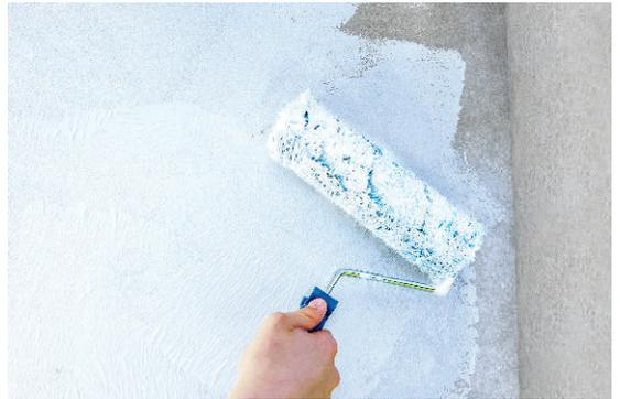
**8. Farbfläche verschlichten:** Nach jeweils etwa drei Bahnen Farbauftrag rollst du – ohne neue Farbe – nochmals über die gerade gestrichene Fläche, um die Farbe optimal zu verteilen.
