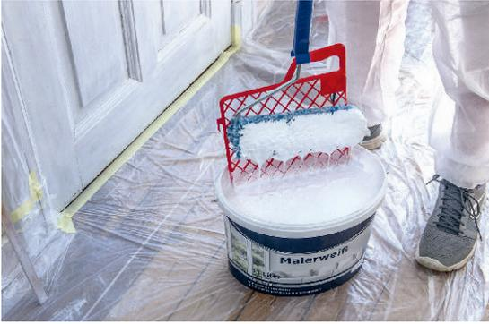
**5. Farbrolle vorbereiten:** Tauch die Malerrolle in die Farbe ein und streif sie am Gitter gut ab. Wiederhol das so lange, bis die Rolle komplett mit Farbe benetzt ist, aber nicht tropft.
