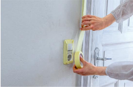
**1. Raum vorbereiten:** Kleb Fußleisten, Tür- und Fensterrahmen, Steckdosen und Schalter mit Kreppband ab. Leg den Boden mit Malervlies oder -folie aus und umwickel auch Heizkörper.
