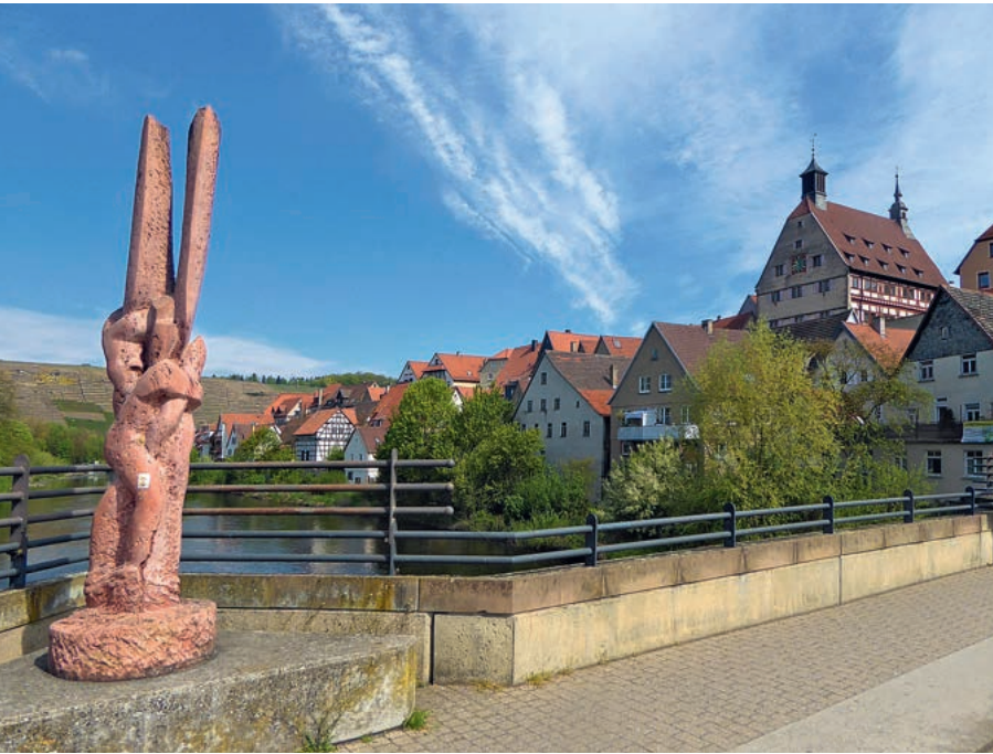
Enzbrücke mit Blick auf Besigheim
