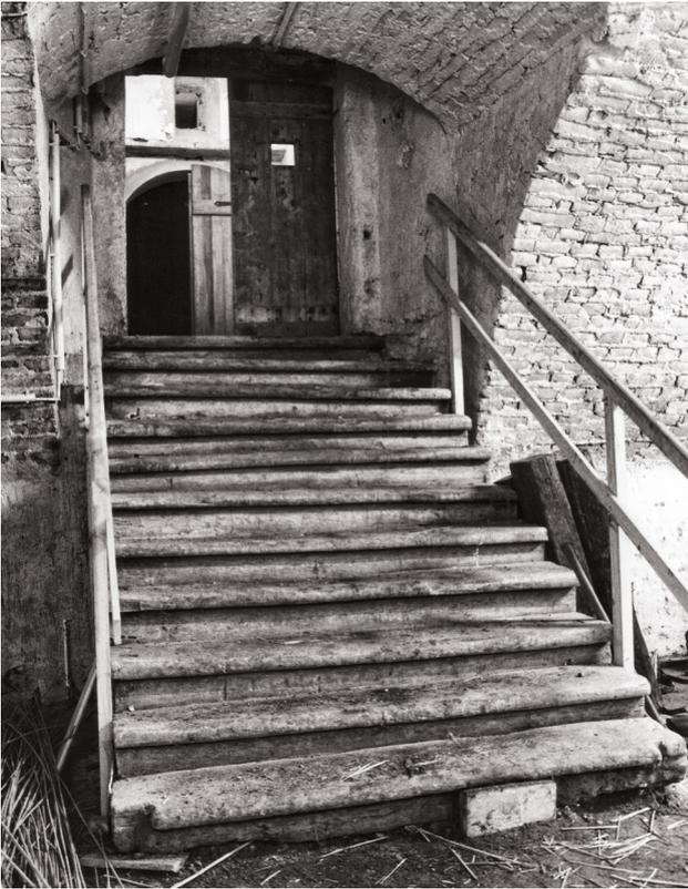
Abb. 26 Orth an der Donau, Schloss. Nordtrakt. Blocktreppe im Kellerraum EG17, um 1334 (Aufnahme 1991).
