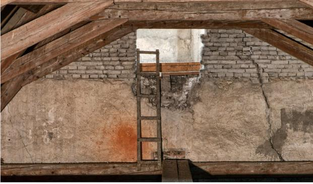
**Abb. 30** Orth an der Donau, Schloss. Nordostturm. Verputzte Südfassade im Dachgeschoß des Osttrakts mit vermauertem Rechteckfenster, vermutlich um 1334.
