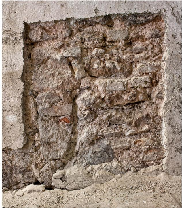
Abb. 27 Orth an der Donau, Schloss. Ostmauer des Raums EG13. Rechts Kompartimentmauerwerk mit Brandspuren, für die Errichtung eines jüngeren Durchgangs (Mitte) abgebrochen, links der Ansatz der Verfüllung des Durchgangs.
