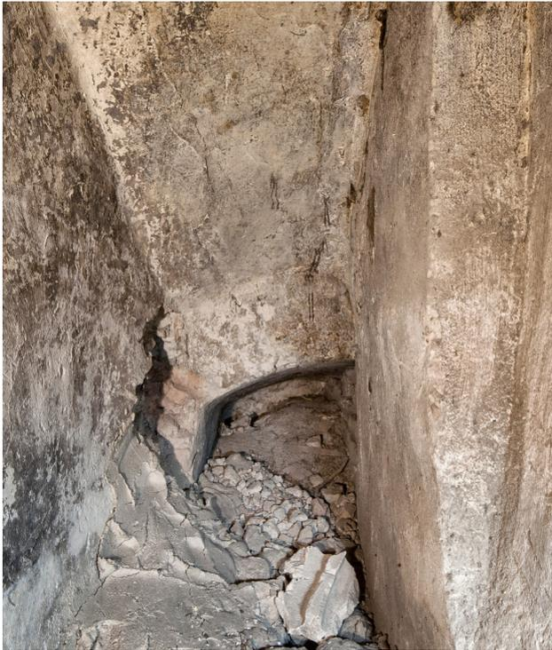
**Abb. 28** Orth an der Donau, Schloss. Nordwestturm, Raum 10G10. Ehemaliger Treppenlauf in der Mauerstärke der Ostmauer.
