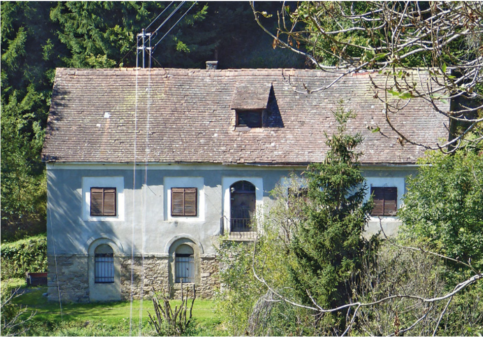
Abb. 4: Lölling, Spitalshaus. Ansicht des Gebäudes von Osten.
