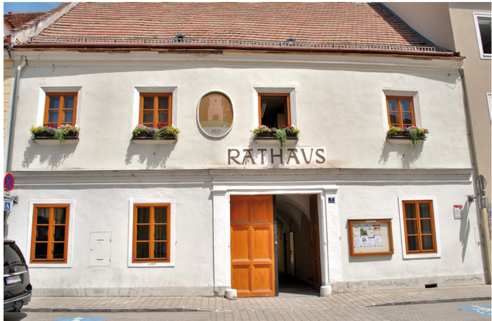
Abb. 35: Traismauer, Rathaus. Straßenfassade (ab 1547 und 1827).
