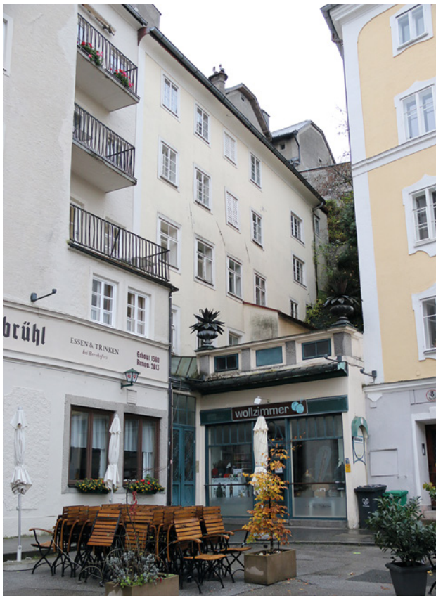
Abb. 3: Salzburg, Bürgerhaus Schanzlgasse Nr. 10. Ansicht des Hauses (Blick von der Schanzlgasse).
