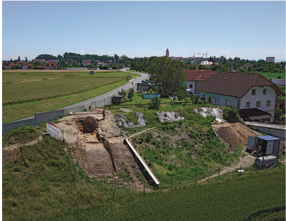
Abb. 3: Enns (Mnr. 45102.16.02). Übersichtsaufnahme der Grabungsfläche mit römischem Kalkbrennofen.
