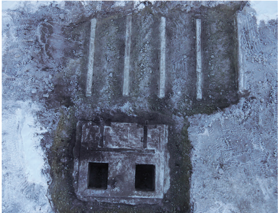
Abb. 3: Haiming (Mnr. 80101.17.01). Baustelleneinrichtung Haiming. Fundamente der Seilbahn (Gebäude L) mit den Fundamenten der Lorenbahn.
