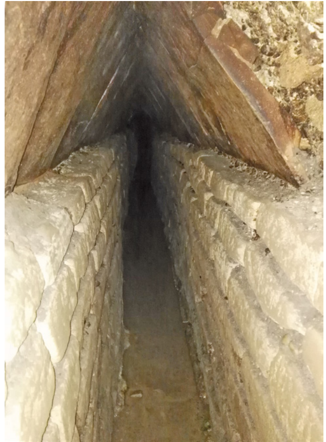
Abb. 21: Petronell (Mnr. 05109.17.08). Blick in die römische Wasserleitung (nach Westen) mit originaler Überdeckung.
