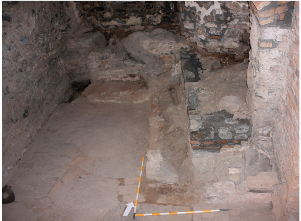
Abb. 2: Burgegg (Mnr. 61005.17.02). Blick in den Untersuchungsbereich von Raum C.
