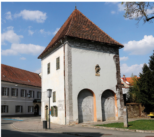
Abb. 1: Radkersburg, Puchhaus. Außenansicht des Gebäudes.
