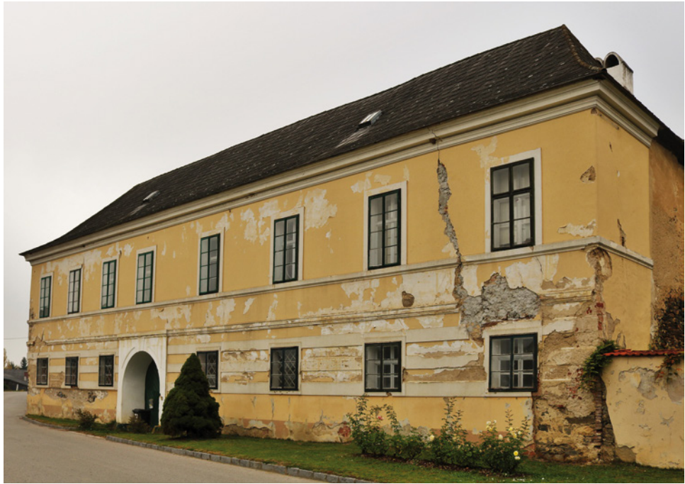
Abb. 7: Felling, Schloss Felling. Fassade des Südtrakts von 1796 (Ansicht von Südosten).
