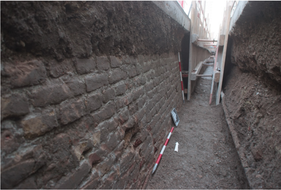
Abb. 7: Innere Stadt (Mnr. 01004.17.15). Ziegelschale der frühneuzeitlichen Kurtine vor dem Haus Dominikanerbastei Nr. 16.
