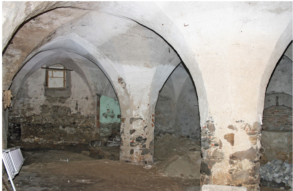
Abb. 5: Dürnstein, Stift. Spätgotische Pfeilerhalle im Erdgeschoß (Blick nach Südwesten).
