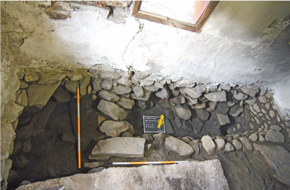
Abb. 8: Ramingstein (Mnr. 58019.17.01). Die wohl als Keller anzusprechende Mauerung im nordwestlichen Raum der Rainerkeusche. Die rezente Gebäudenordmauer sitzt auf der Kellerverfüllung auf, während außerhalb des Kellers ein annähernd lagiges Fundamentmauerwerk sichtbar ist (Ansicht von Südwesten).
