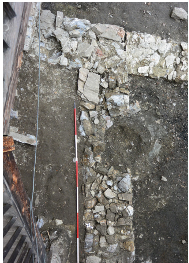
Abb. 3: Friesach (Mnr. 74302.17.01). Mauerwerk des romanischen Kernbaus (SE 141).
