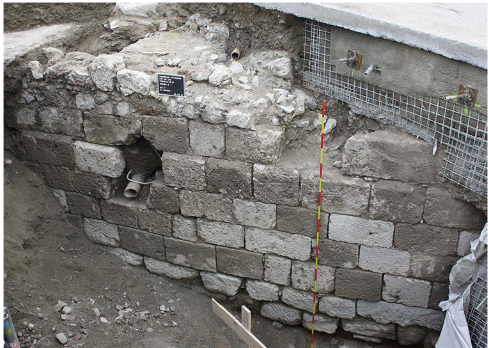
Abb. 6: Innsbruck (Mnr. 8113.16.01). Südlicher Abschnitt der freigelegten spätmittelalterlichen Innufermauer mit Außenschale aus Brecciequadern.
