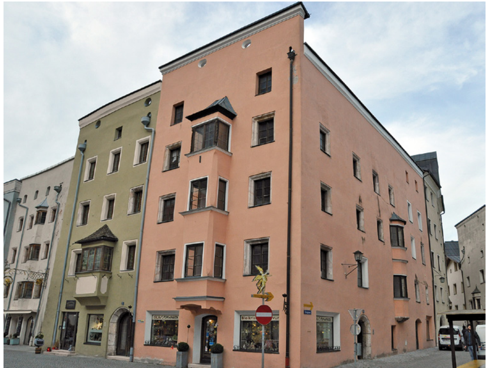
Abb. 9: Rattenberg, Bürgerhaus Inngasse Nr. 52. Ansicht des Eckgebäudes (Blick von Osten).
