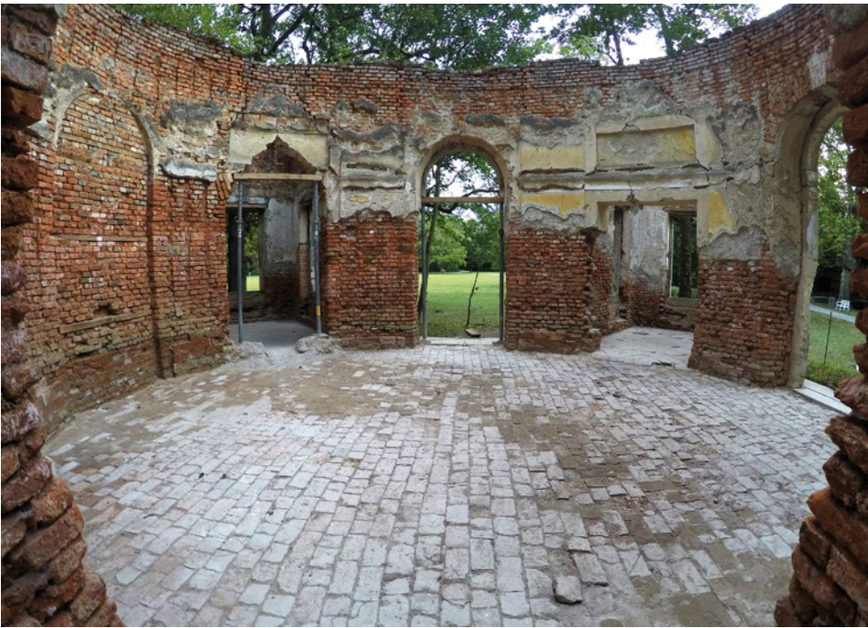
Abb. 17: Laxenburg (Mnr. 16117.17.01). »Haus der Laune« im Schlosspark Laxenburg. Blick in den ellipsoiden Zentralraum mit Ziegelsubstruktion für den abgekommenen Kalksteinplattenboden.
