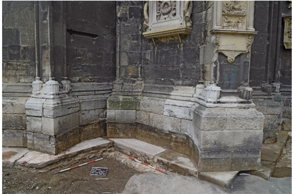
Abb. 4: Innere Stadt (Mnr. 01004.17.02, 01004.17.09). Fundament des Nordturms des Stephansdomes (Blick nach Südwesten).
