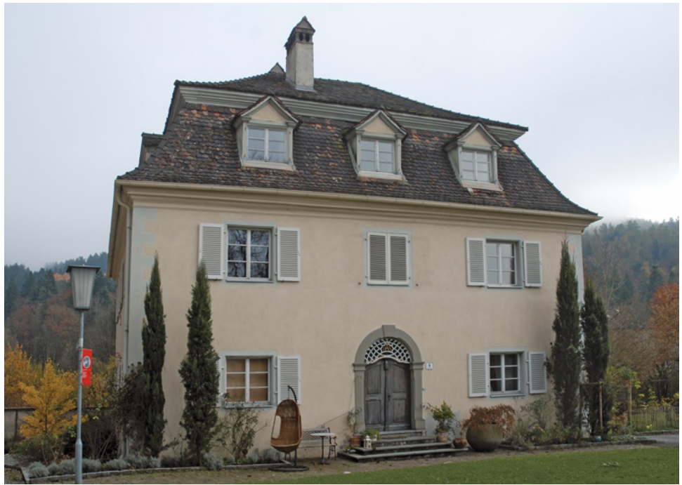
Abb. 1: Bregenz, Praebendehaus. Ansicht des Gebäudes.
