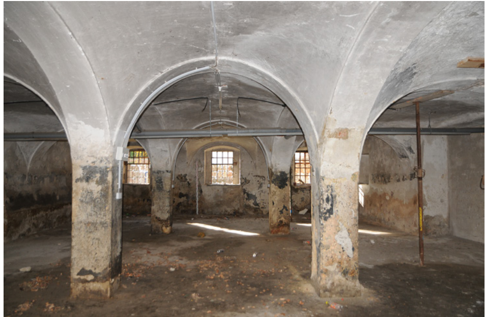
Abb. 16: Lichtenwörth, Nadelburg. Ehemaliger Pferdestall im Erdgeschoßraum 02 des »Langen Ganges« (Blick gegen Süden).
