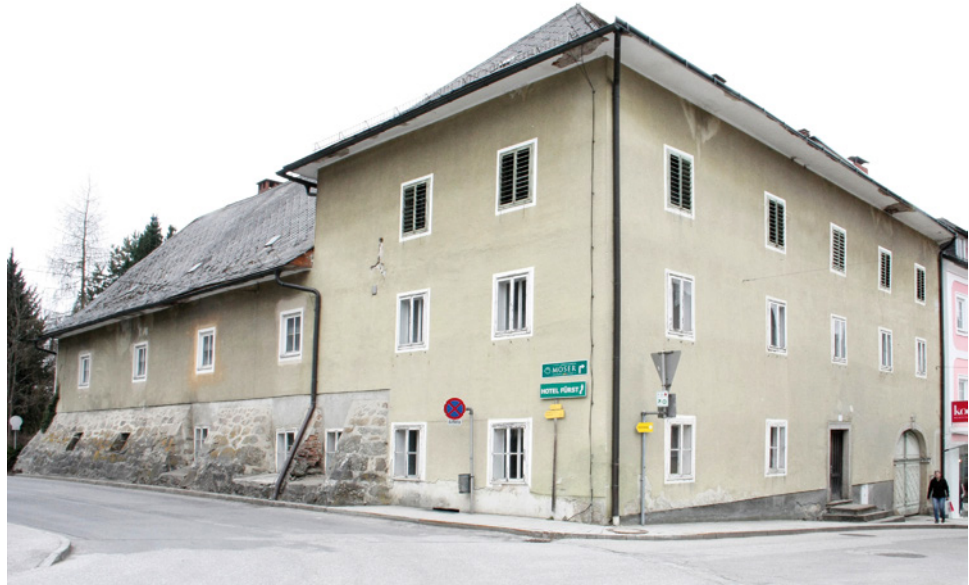
Abb. 7: Unterweissenbach, ehemaliges Bezirksgericht. Ansicht der Straßenfassaden (Blick nach Westen).
