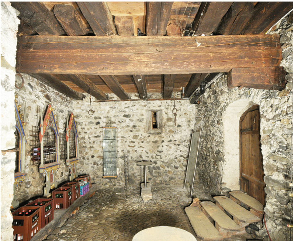
Abb. 3: Fügen, Widum. An die Kirchenwestfassade (links) angrenzender Keller o.05 des romanischen Widums aus dem späten 13. Jahrhundert. Dazu gehören die Mauer im Hintergrund mit dem Schlitzfenster und die Balkendecke; die Wand rechts im Bild wurde in spätgotischer Zeit eingestellt.
