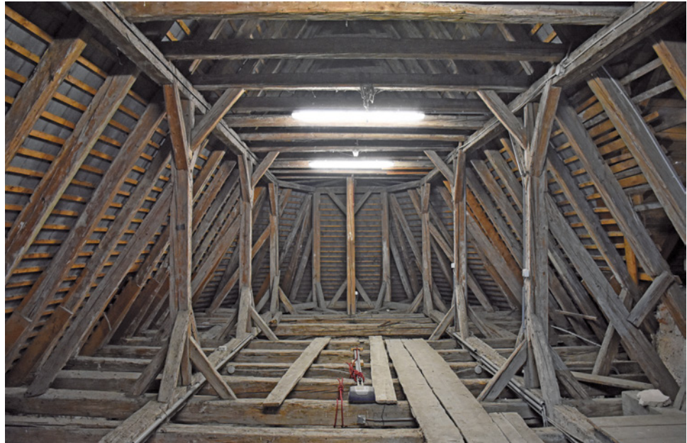
Abb. 39: Weidling, Pfarrkirche hll. Peter und Paul. Blick Richtung Osten in den Dachstuhl (nach/um 1679d).
