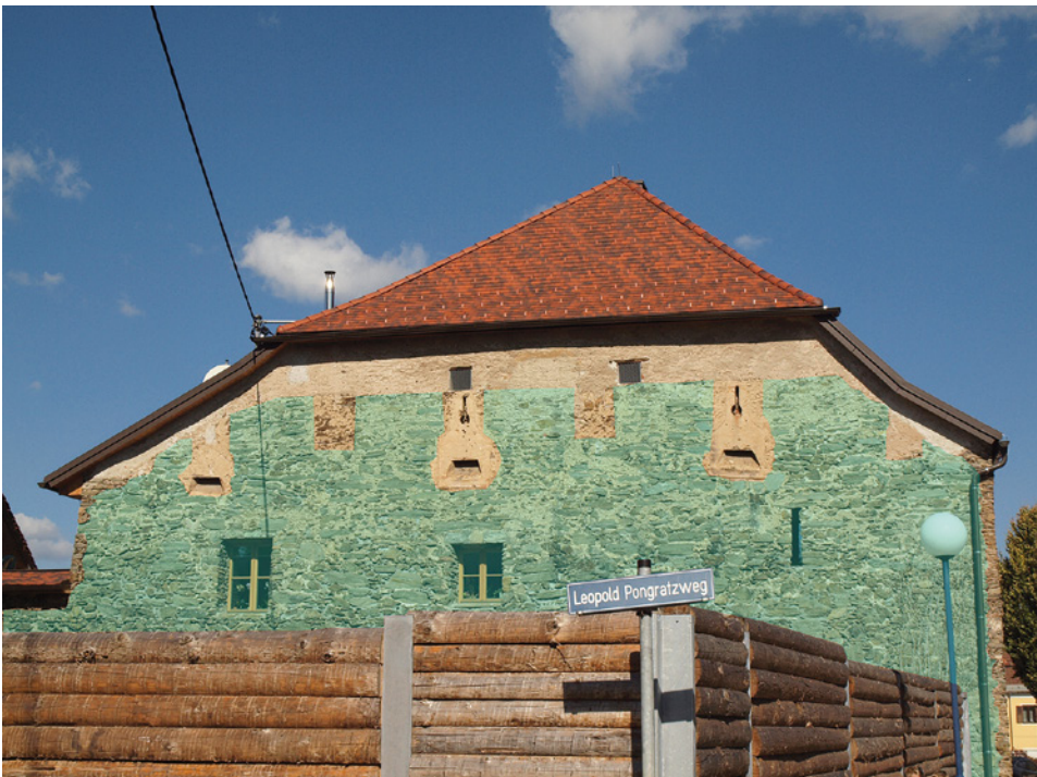
Abb. 6: St. Andrä, Stadtbefestigung. Stadtmauer westlich des ehemaligen St. Pauler Tores. Die bauzeitlichen Zinnen samt Mauerwerk der Bauphase um/nach 1339 sind farblich gekennzeichnet. Die Schlüsselloch-beziehungswise Senkscharten mit Putzrahmungen stammen aus der Zeit um 1480/1500.
