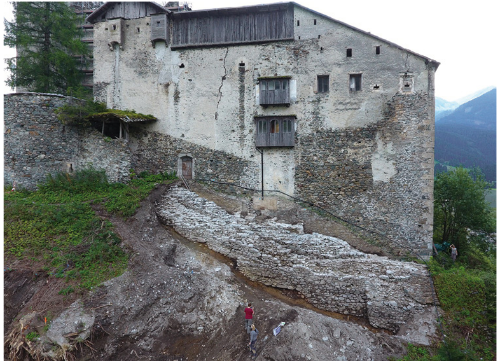
Abb. 13: Heinfels (Tir.). Nordseite der Burg mit freigelegten Ringmauern im Vordergrund.
