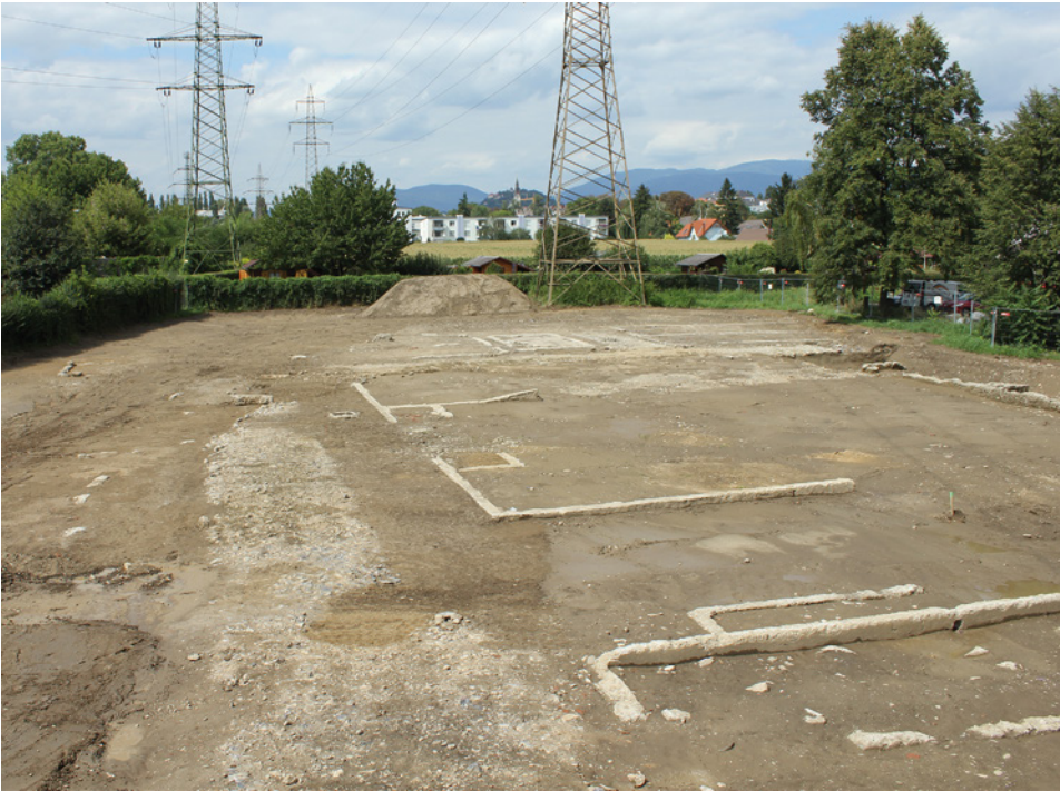
Abb. 8: Liebenau (Mnr. 63113.17.01). Barackenfundamente und Lagerstraße des NS-zeitlichen Lagers (Ansicht gegen Norden).
