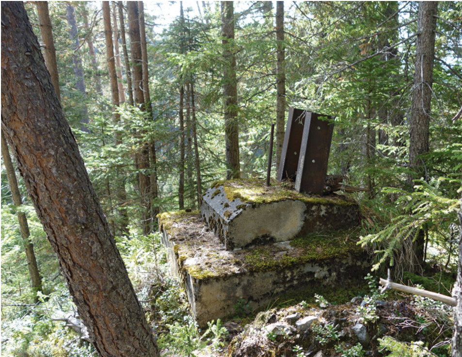
Abb. 4: Haiming (Mnr. 80101.17.02). Betonsockel mit Stahlträger einer Stütze der Materialseilbahn über den Amberg.
