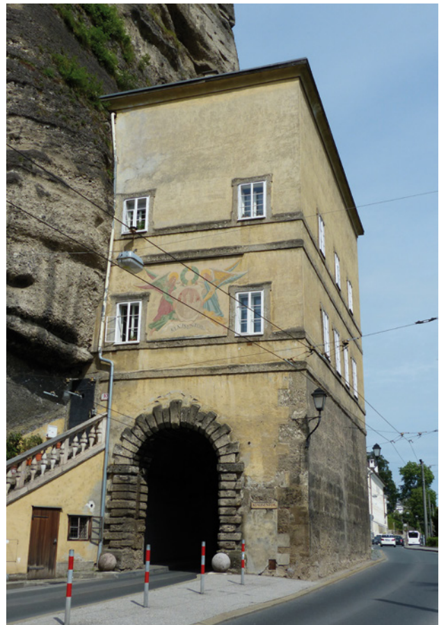
Abb. 5: Salzburg, Klausentor. Ansicht des Torbaus von Süden.
