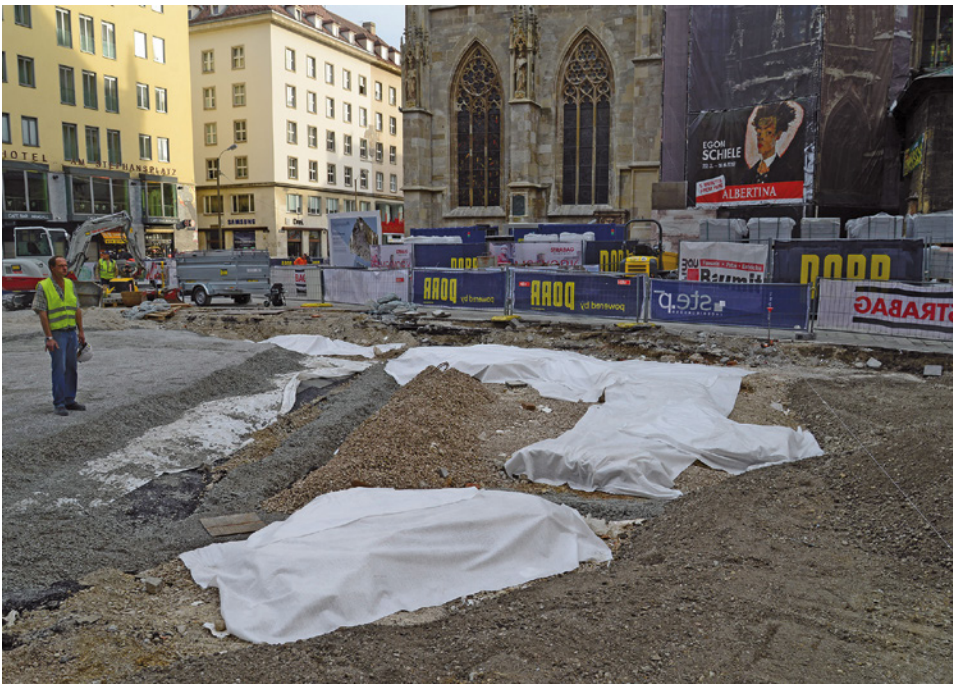
Abb. 16: Wien, Innere Stadt. Sicherungsmaßnahmen über der Virgilkapelle.
