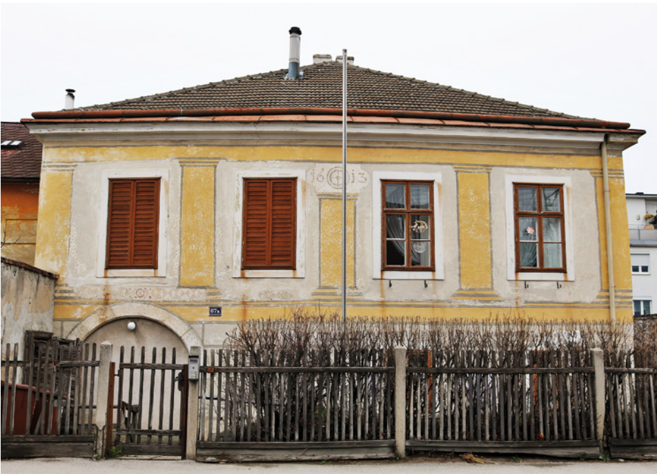
Abb. 22: Mödling, Putzschmühle. Südfassade (1713).
