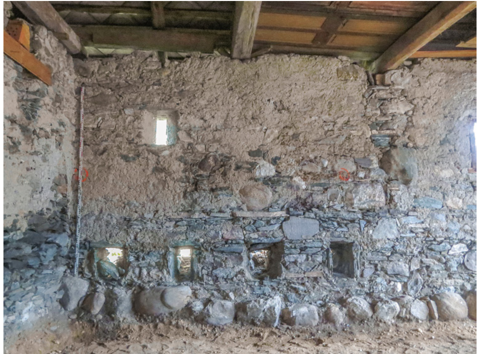
Abb. 3: Feldkirchen, Pfarrhof. Innenansicht der Südfassade des spätgotischen Wirtschaftsbaus.
