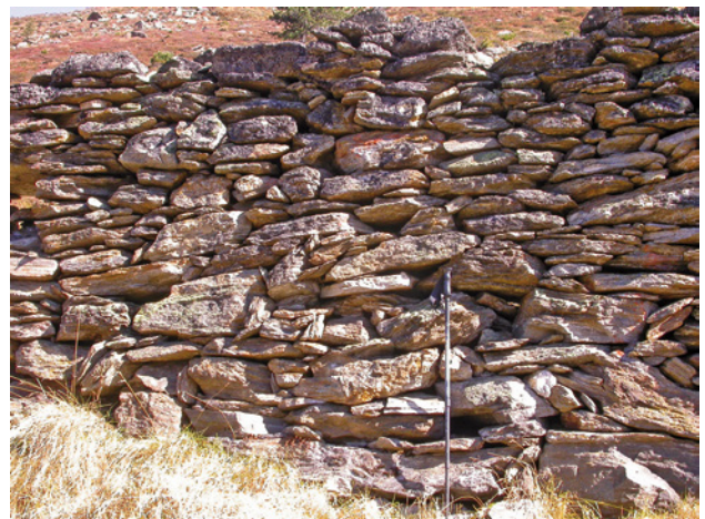
Abb. 159: Sorgfältig geschichtete hangseitige Mauer der einstigen Almhütte der Schönlisensalm.
