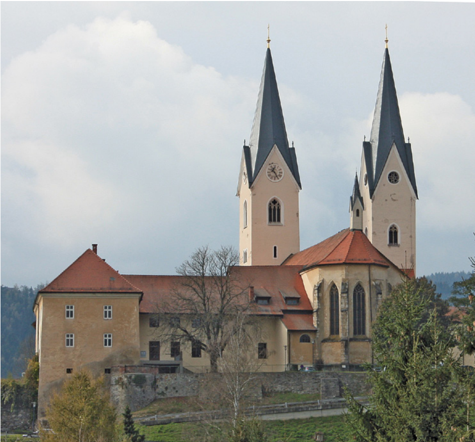
Abb. 8: St. Andrä, Pfarrkirche hl. Andreas und Propsteihof. Ansicht von Osten.
