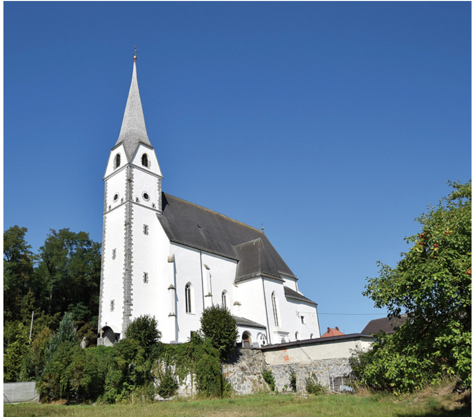
Abb. 3: Taufkirchen an der Pram, Pfarrkirche Mariae Verkündigung. Ansicht von Südwesten.
