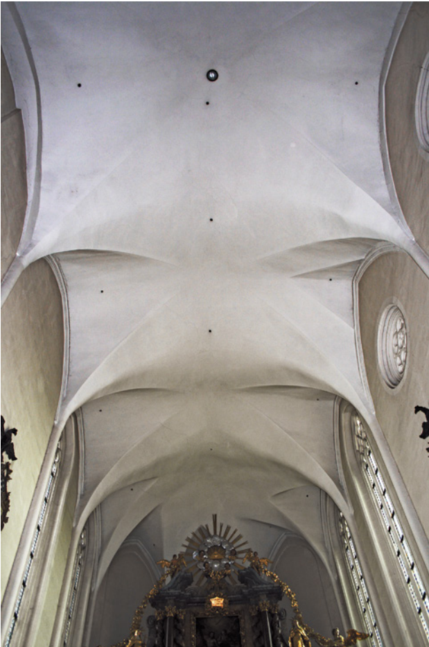
Abb. 13: Klosterneuburg, Pfarrkirche St. Martin. Gewölbe des Chors (ab 1419 bis Ende 15. Jahrhundert). Die abgeschlagenen Rippen sind im Streiflicht zu erkennen, ebenso die schmalen Stichkappen. Rechts im Bild die beiden Okuli über dem Seitenchor.
