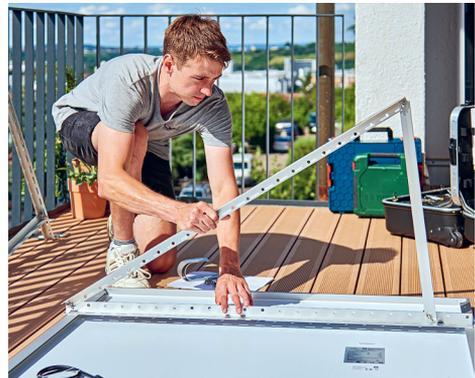
**08** Die Panelträger an den vorgelochten Stellen der Panelrahmen festschrauben.
