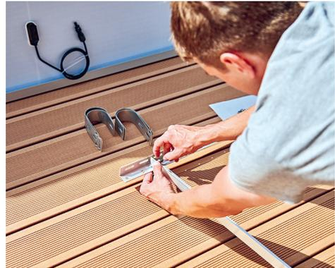
**06** Die Gerüstelemente der Balkonbefestigung zusammenschrauben und den Winkel zur optimalen Ausrichtung der Solarpanels vorgeben.
