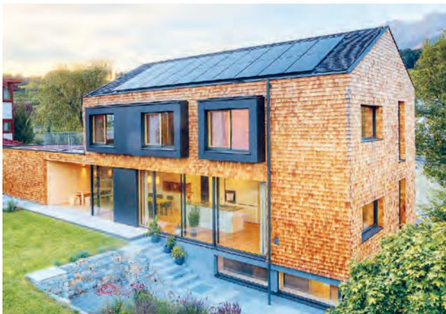
Passivhaus in Holzrahmenbauweise mit Zellulosedämmung und Photovoltaikanlage am Steildach
