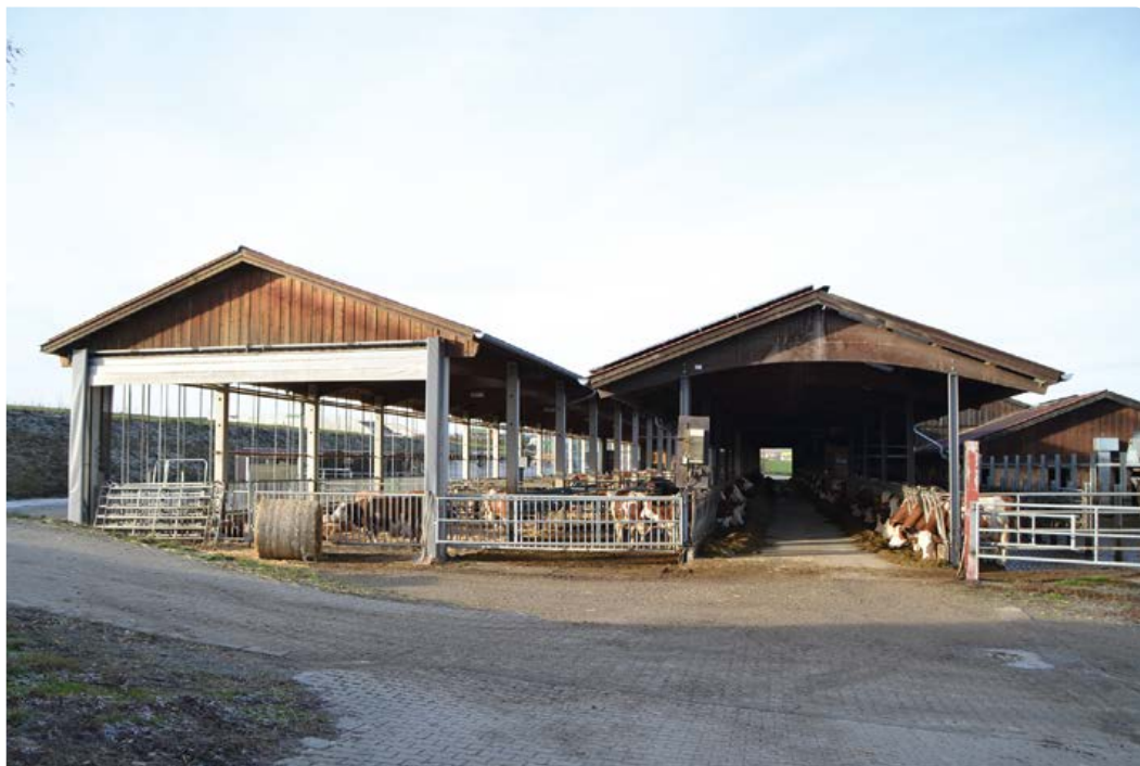
Abb. 2: Mehrhäusiger Laufstall mit integriertem Freigeländezugang im Fressbereich
