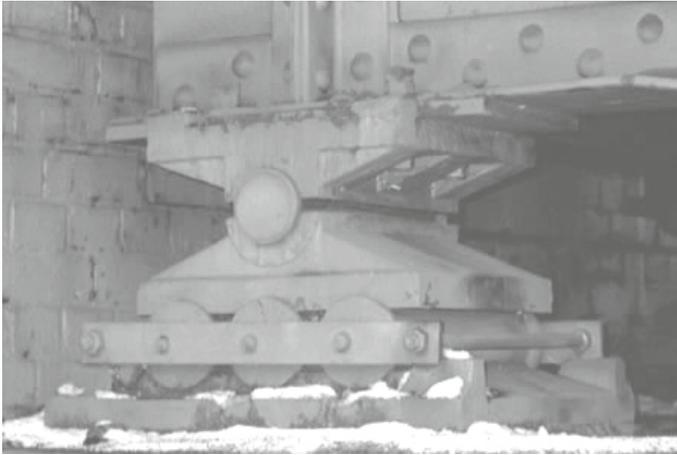
**Bild 3.13** *Loslager*: Die Abbildung zeigt ein altes Mehrrollenbrückenlager an einer Eisenbahnbrücke über die Spree in Cottbus [3.4]. Dabei sorgt der obere zentrale Bolzen für die Kippbeweglichkeit und die unteren drei Rollen für die horizontale Verschieblichkeit.
